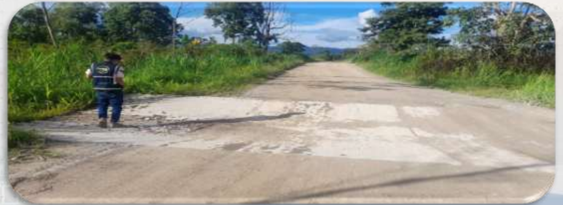
Inventario de obras de drenaje transversal
