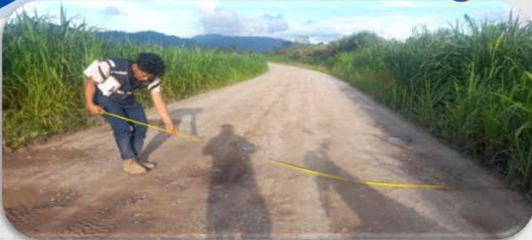
Medición de ancho de calzada
