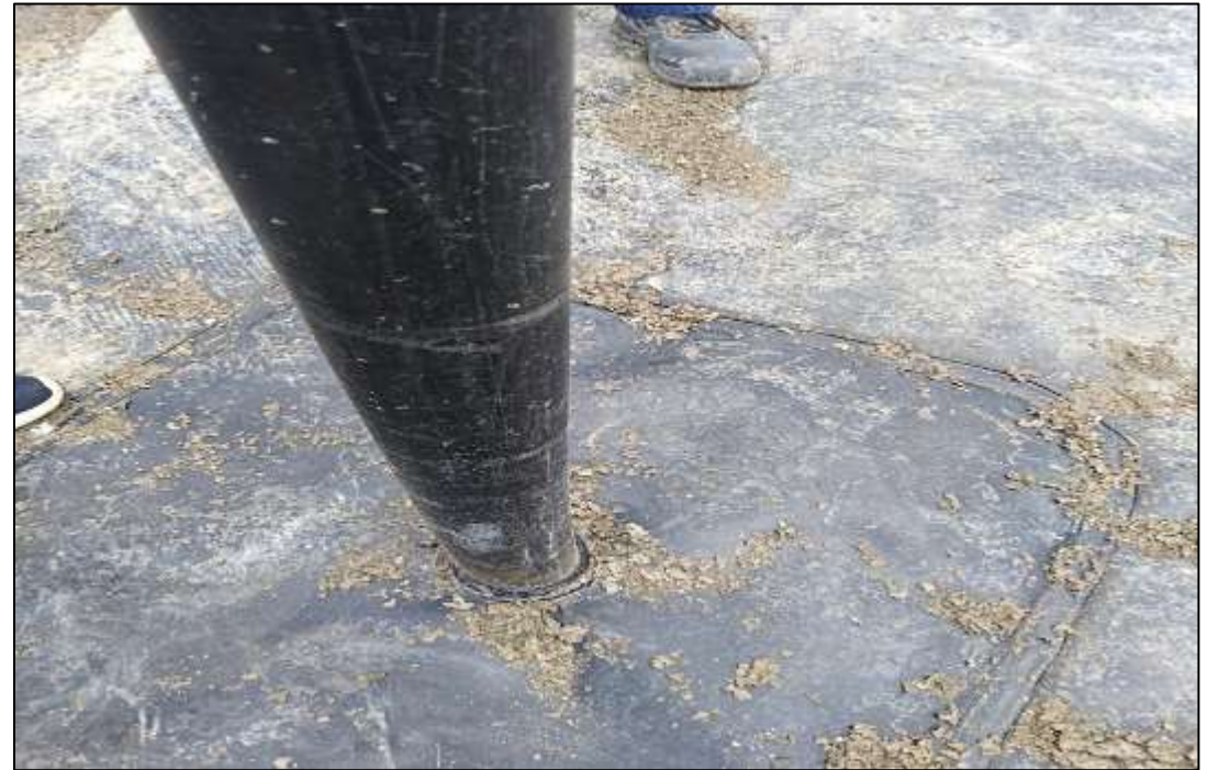
INSTALACION DE AERADORES EN PUNTOS ROTOS
