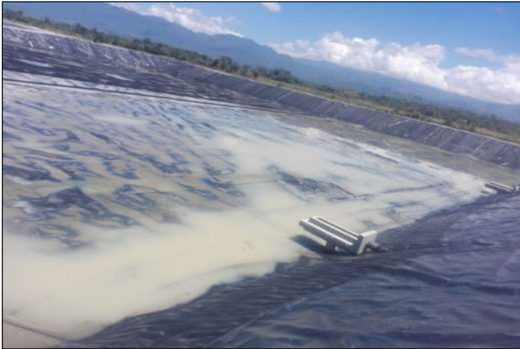
LAGUNA DE MADURACION SECADA PARA INSTALAR AERADORES
