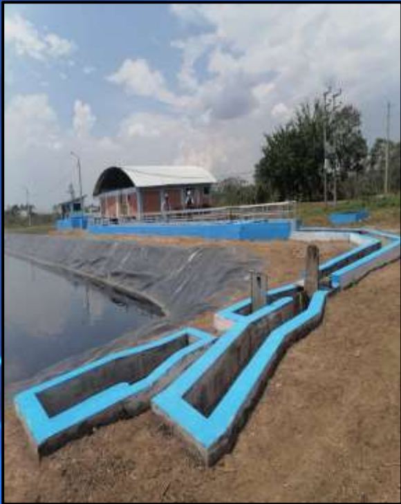
DESARENADOR Y CAMARA DE CLORACION
