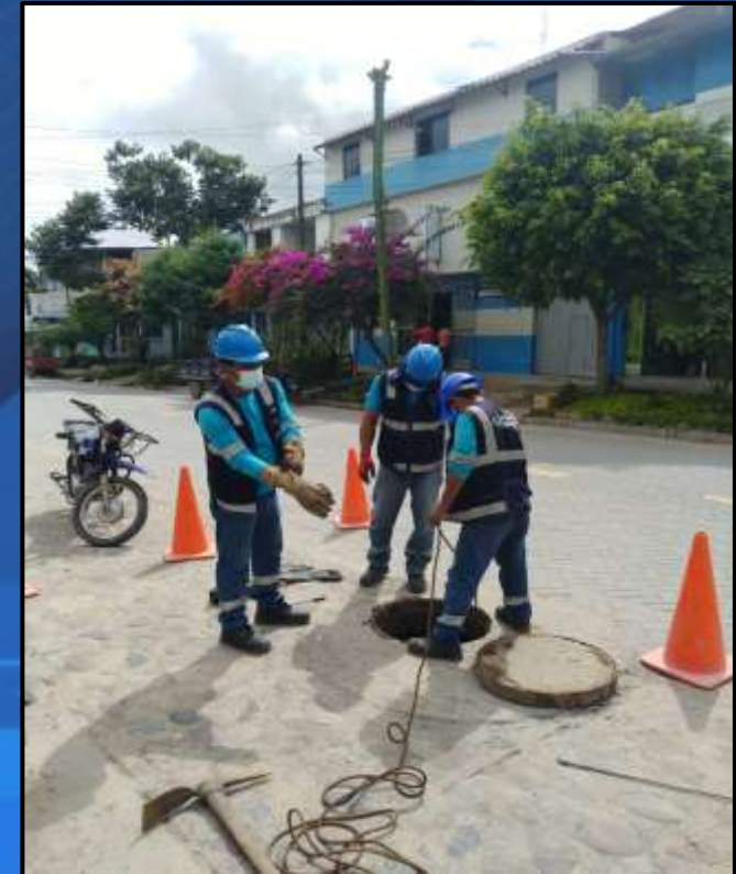
MANTENIMIENTO DE COLECTORES
