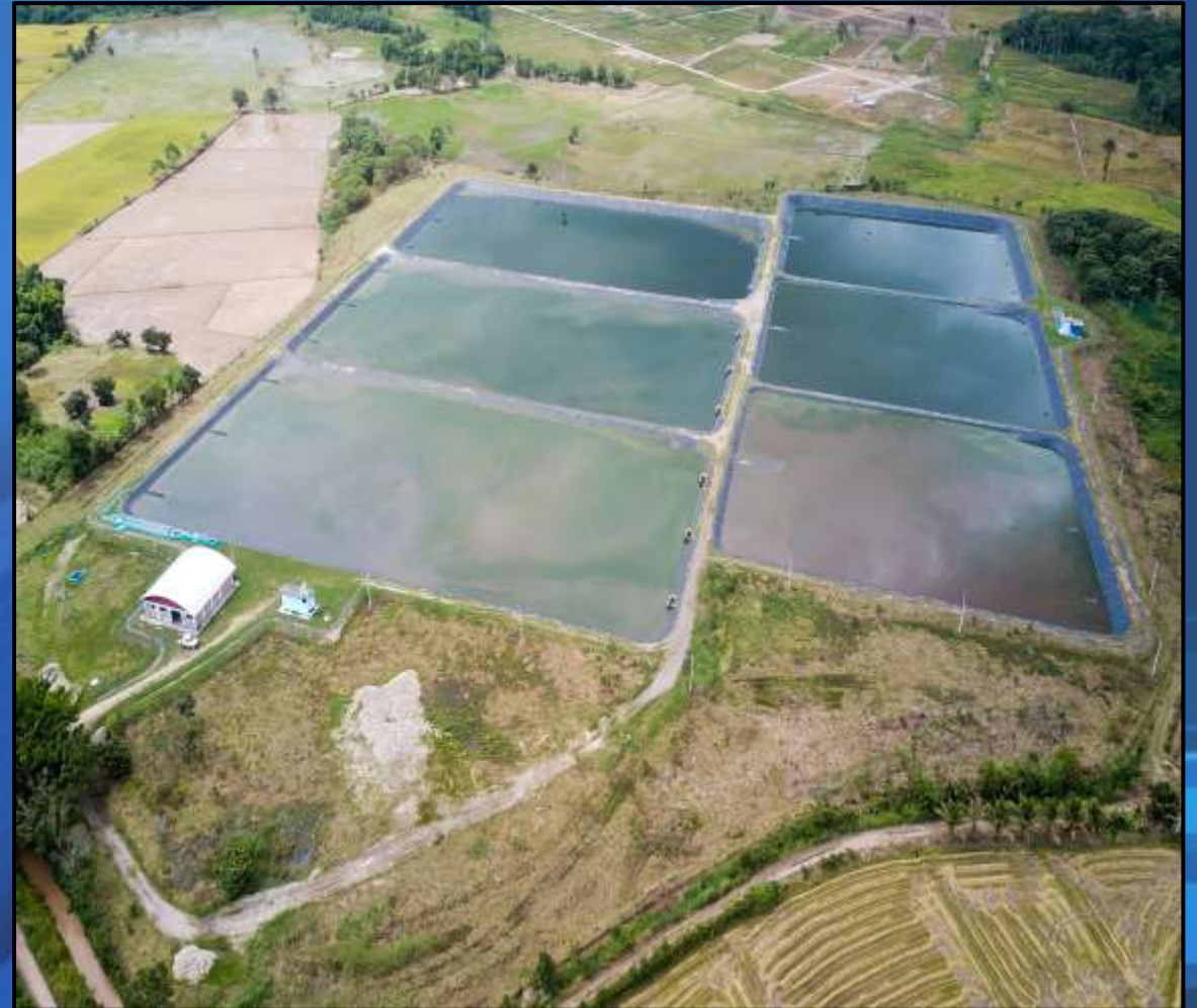
LAGUNAS REPARADAS – SISTEMA DE CLORACION
