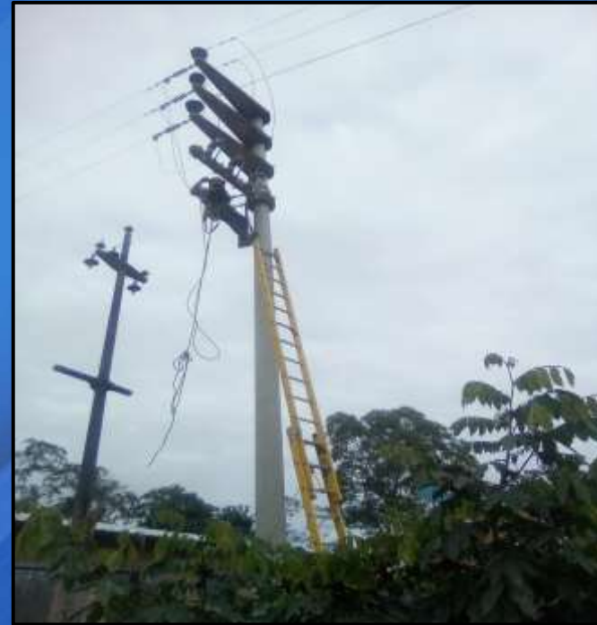
RENOVACION DE TRANSFORMADOR SECTOR DEMOCRACIA
