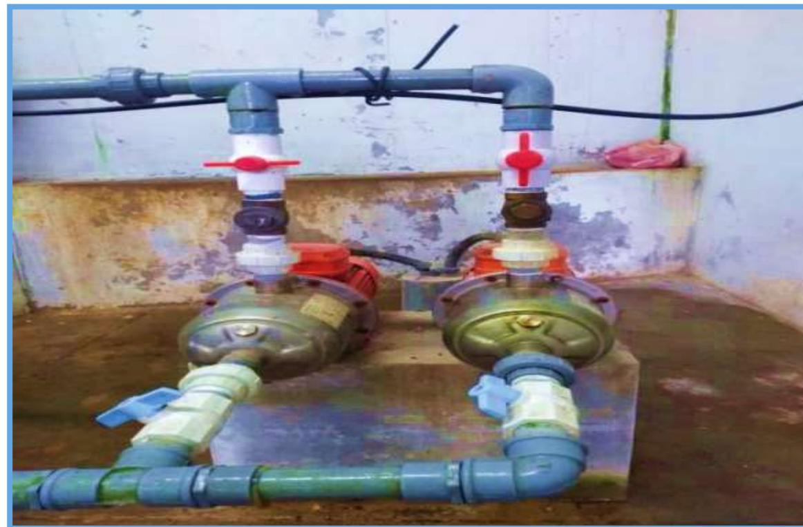
**BOMBAS BOSSTER PARA SISTEMA DE INYECCION AL VACIO**
